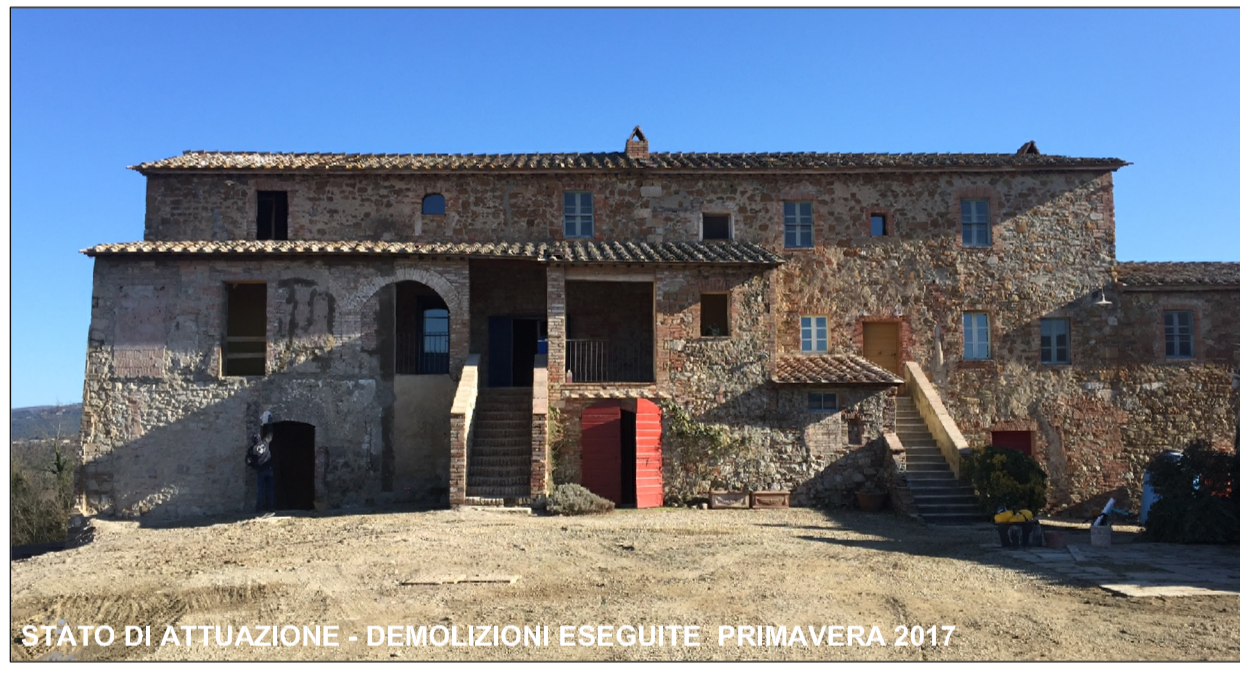
STATO DI ATTUAZIONE - DEMOLIZIONI ESEGUITE PRIMAVERA 2017
